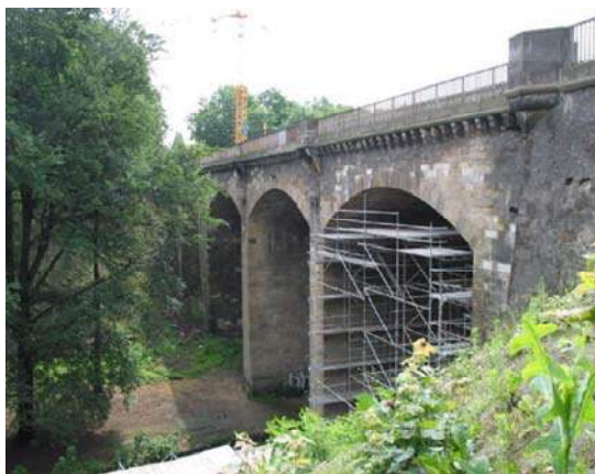
Fig. 3: Straßenbrücke mit Kreisbögen und konstanter Bogendicke
