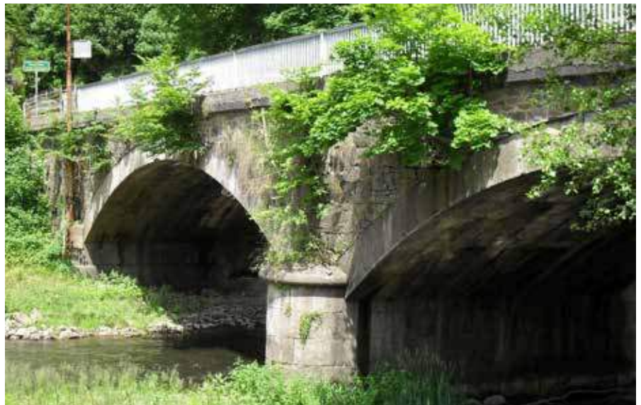
Bild 1: Bestandsansicht Oberstrom vor Instandsetzung
